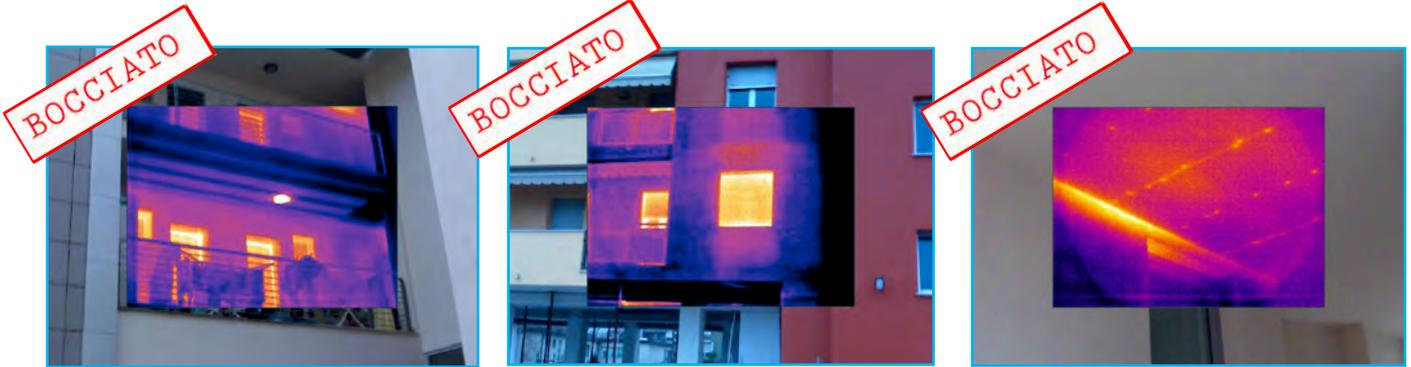
Nelle immagini di dettaglio è possibile notare alcuni particolari che mettono in luce la dispersione termica di serramenti e di solai. Nelle foto in basso invece è possibile vedere ponti termici, orizzontali e verticali, di pilastri e solai oltre che le dispersioni dei serramenti.
