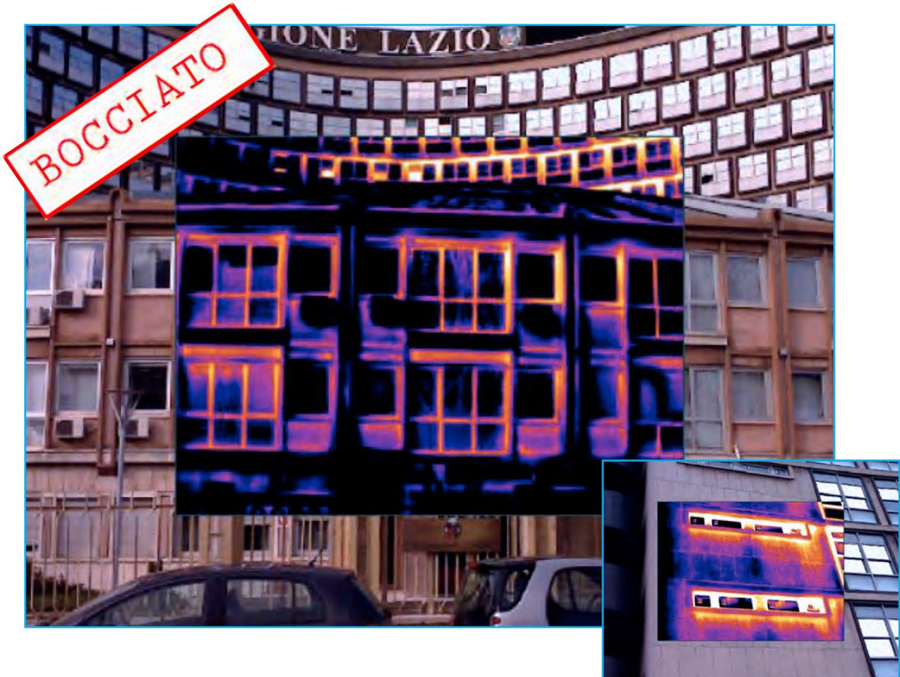
Le termografie relative all'edificio della Regione Lazio mettono a nudo i difetti termici dell'involucro edilizio e in particolare i ponti termici sulla facciata Nord - Nord Ovest dove sono ben visibili i solai e le dispersioni termiche delle soglie delle finestre a nastro. Lo stesso per il dettaglio della facciata Nord dove si notano le perdite dei serramenti e il ponte termico della struttura orizzontale del solaio.
