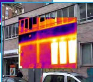
Anche per quanto riguarda l'indagine eseguita sulla sede distaccata della Regione Lombardia è possibile notare i ponti termici sulle strutture portanti orizzontali e verticali.
