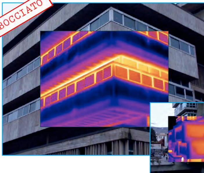
Sulla struttura del tribunale di Potenza sono ben visibili le orditure e i ponti termici dei solai. Lo scarso isolamento della facciata laterale, nella seconda immagine, evidenzia la differenza di temperatura delle superfici in rilievo non riscaldate e quella delle facciate a diretto contatto con un ambiente condizionato la cui differenza cromatica disegna i due vani riscaldati.
